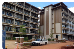
14 · อาคาร · โรงแรม Romantic Residence คสล. 6 ชั้น 44 ห้อง 2 อาคาร โรแมนติค เรสซิเดนซ์ เขาใหญ่
