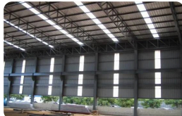
03 · ปรับปรุงโรงงาน · งานระบบ งานโครงสร้าง อาคาร · ระบบน้ำหล่อ เย็น ท่อแก๊ส ท่อลม ซินเอ ไฮเทค
