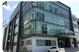
09 · โรงงาน · โคดัง อาคารโรงงาน- ออฟฟิศ คสล. 5 ชั้น + ตกแต่งภายใน นาตาชา ครีเอชั่นส์
