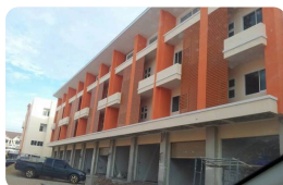
12 · อาคาร · โรงแรม อาคารพักอาศัย หจก. โนเบิลแลนด์พร็อพเพอร์ตี้
