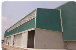
08 · โรงงาน · โคดัง อาคารโรงงาน น้ำชัยเพาเวอร์ซีฟพลาย
