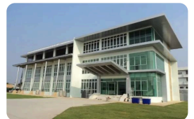
10 · อาคาร · โรงแรม อาคารสำนักงานพักอาศัย ต๋องบุญเอกเสก จ.นครราชสีมา
